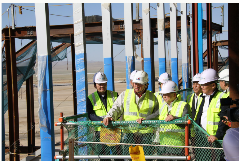
Шинэ нисэх буудлыг гэрээний хугацаанд буюу 1296 хоногт барьсан
