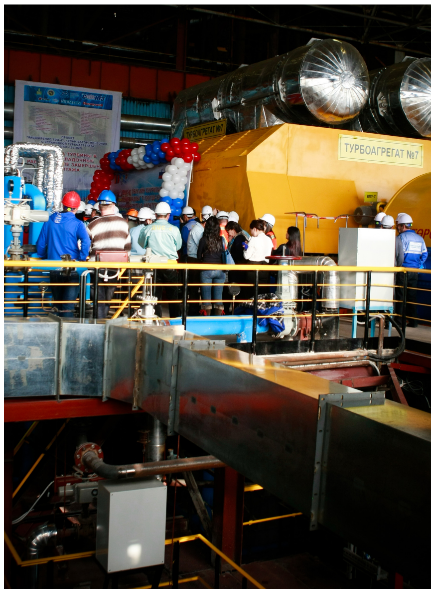
“ДЦС-4” шинээр суурилуулсан турбин
