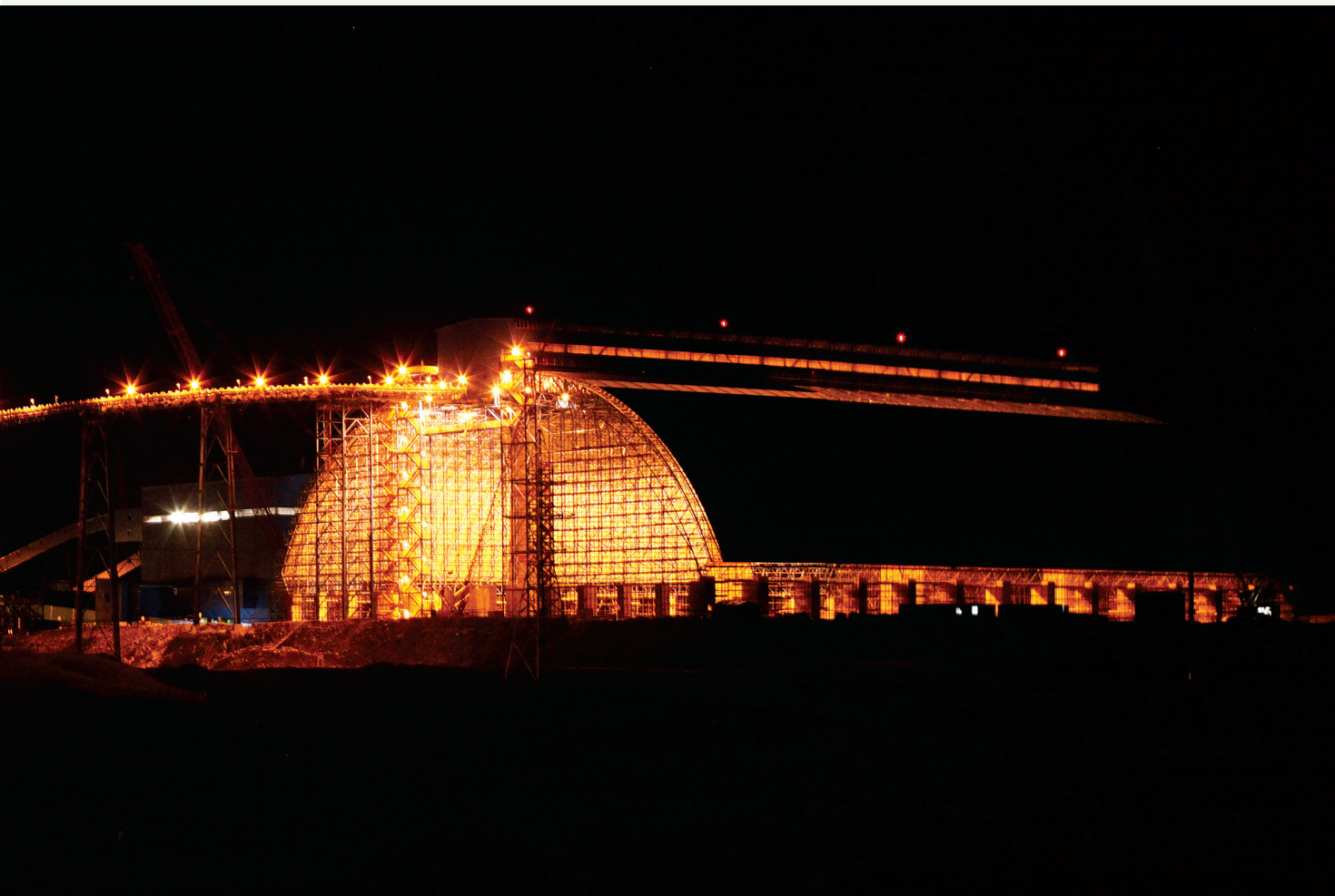
Оюутолгойн Баяжуулах үйлдвэрийн хүдэр хадгалах байгууламж
